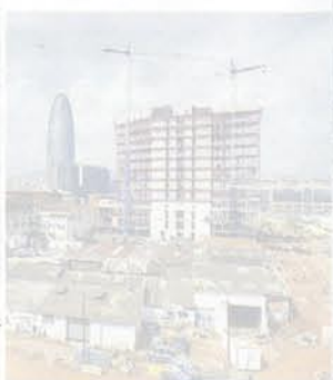
Viviendas en construcción en el 22@.
